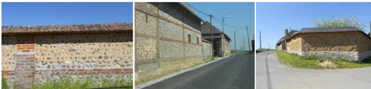
Forte présence des façades aveugles des anciens bâtiments agricoles (murs, façades...)
