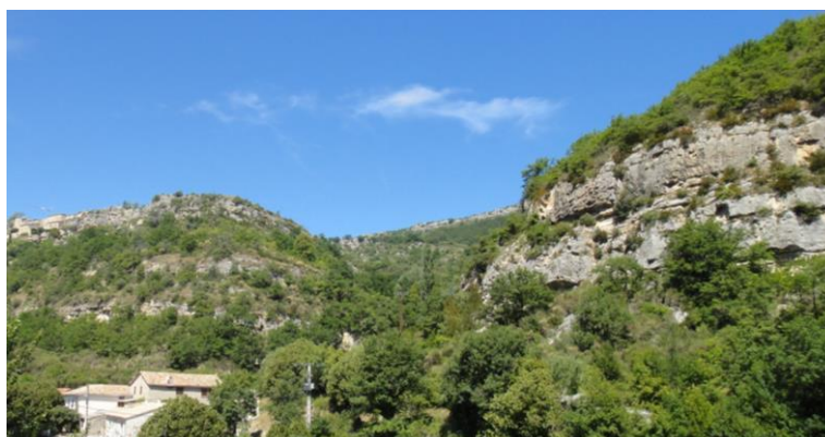
Photographie 7 : Escarpement rocheux surplombant le Moulin de Vercoiran
