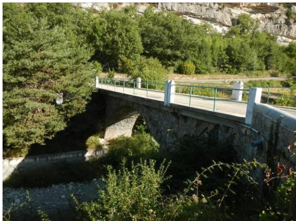
Pont du moulin de Vercoiran
