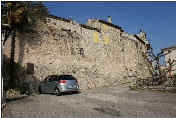
Les pentes assez fortes du coteau d'implantation du village ont conduit à des terrassements importants pour créer la place du lavoir. Ainsi un mur imposant en pierres domine cette place.
