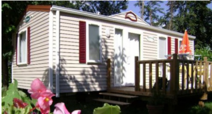
Éviter ce type de constructions
