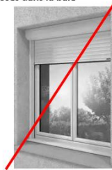
Pose sous linteau avec coffre saillant par rapport à la menuiserie
