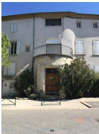
Enduit de finition fine et mur en pierres de taille laissées apparentes (à gauche)
