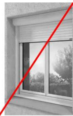
Pose sous linteau avec coffre saillant par rapport à la menuiserie
