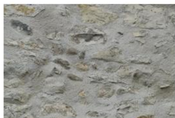
Joints à pierres vues
