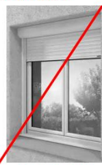
Pose sous linteau avec coffre saillant par rapport à la menuiserie
