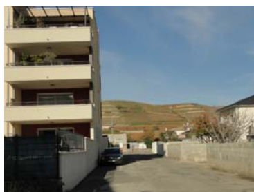
Photo prise en secteur A, à l'interface avec les coteaux viticoles (site classé), où il serait souhaitable de maîtriser les hauteurs de bâtiment.
