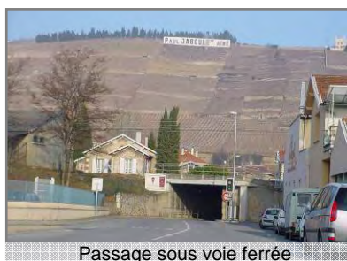
Passage sous voie ferrée
