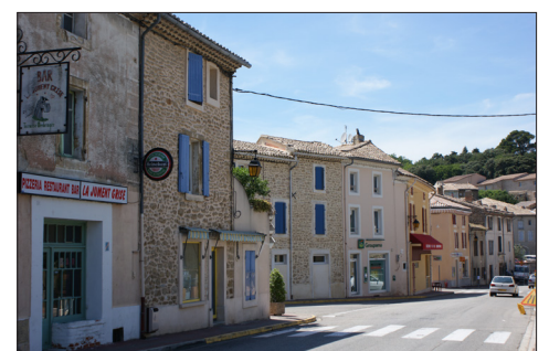
L'alignement des percements, lignes d'égouts de toiture, les largeurs de façades souvent similaires et enduits colorés constituent et caractérisent les faubourgs.
