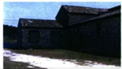
vu du pignon nord depuis l'ouest
