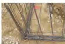
Nœud de chaînage - Continuité mécanique
