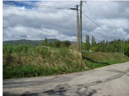
Le talus vu du chemin des Comtes
