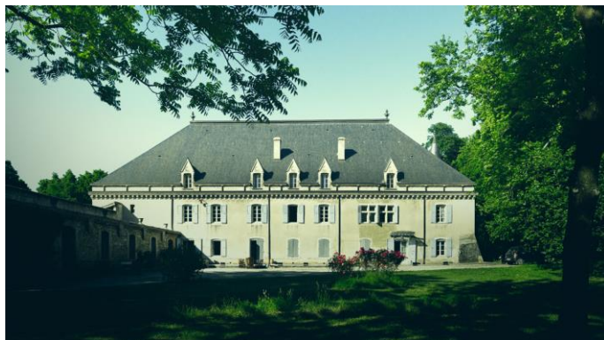
Façade principale du Château Freycinet
