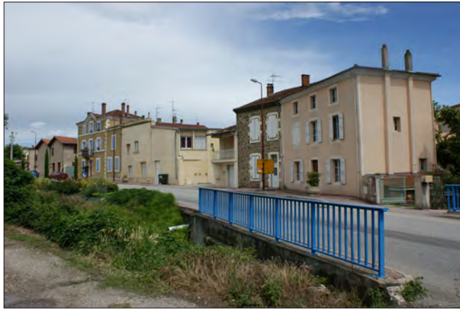
Les logements en façade de rue.
