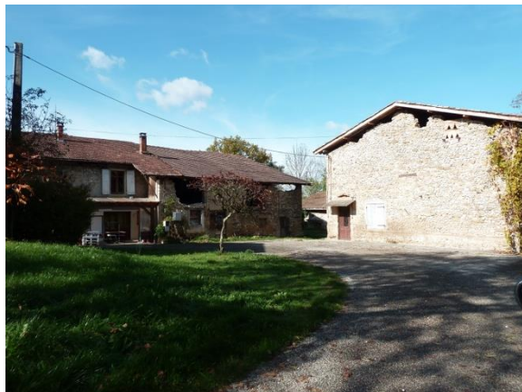
Corps de ferme en cours
