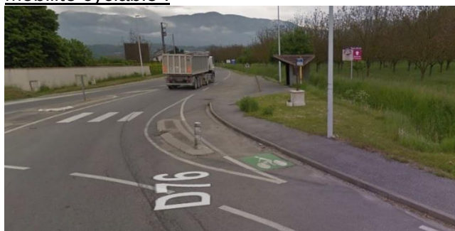
Sécurisation de la croisée de Manne
