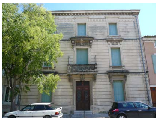
Mur en pierre de taille
