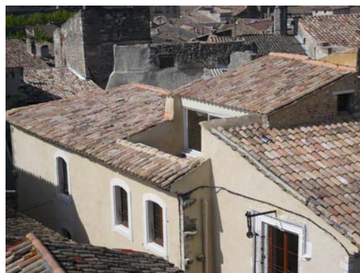
Terrasse en toiture, exemple intéressant
