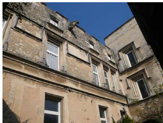
Les façades les plus belles sont souvent à l'intérieur des cours. Hôtel Narbonne-Pellet.
