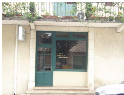
Vitrine correctement positionnée à l'intérieur des ouvertures.
