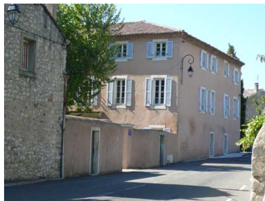
Les façades de l'habitation sont enduites.
