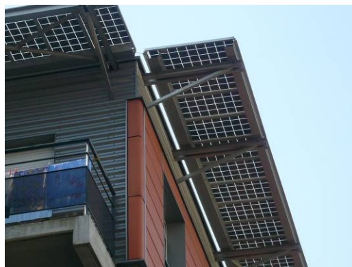
Capteurs solaires pare-soleil, Grenoble
