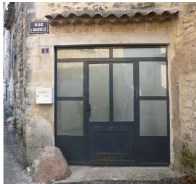
Préférer une composition de menuiserie à l'intérieur de l'ouverture d'origine, positionnée en retrait du mur .
