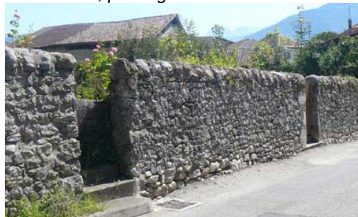
Exemple de percements intéressants dans un mur ancien, Le Touvet (38)
