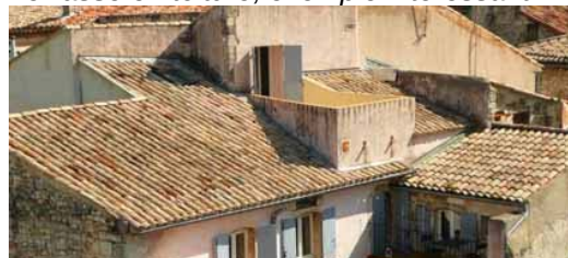
Terrasse de toit en excroissance, interdit
