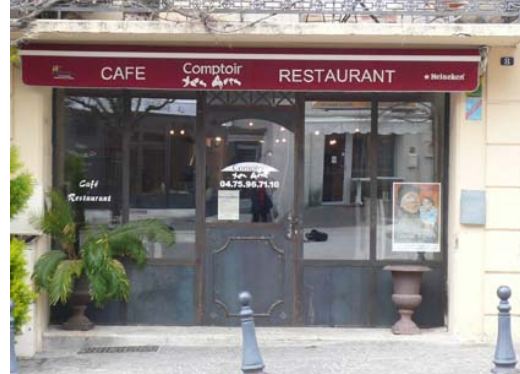
Store de protection solaire bien positionné
