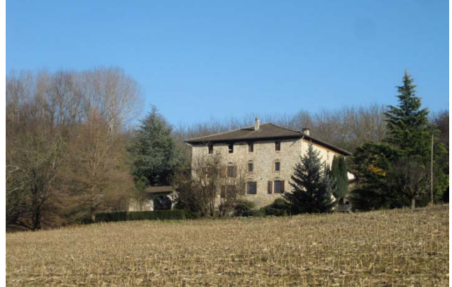
« ferme Vignon », maison ancienne
