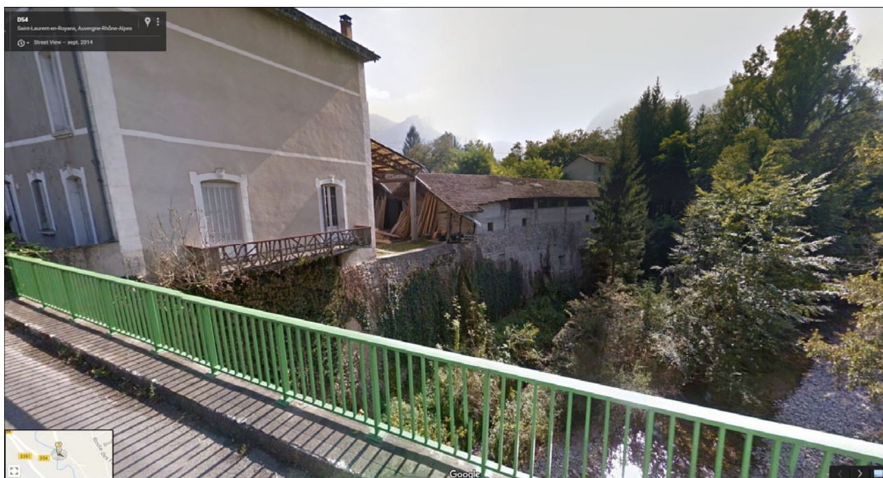
En amont du Pont du Cholet (Source : Streetview – septembre 2014)
