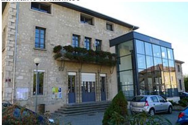
La mairie réhabilitée
