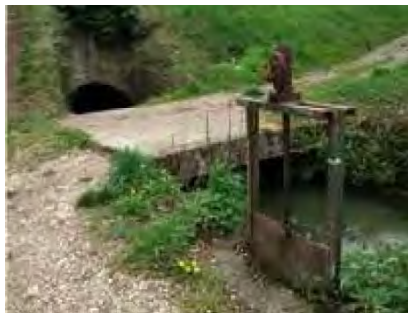
5-Canal de la Lyonne, partie nord
