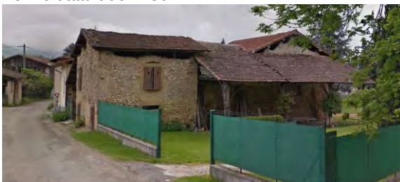
23 – Architecture agricole, les Macaires Ferme datant de 1750
