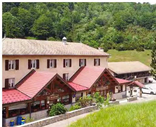
Vue depuis l'est : façade sur la RD76
