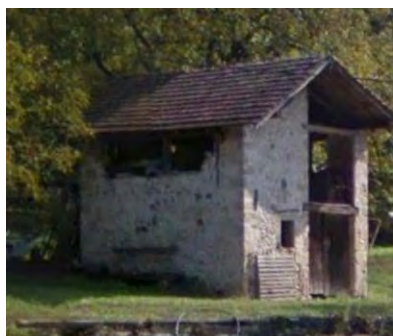
33 – Architecture agricole, le Pont de la Dame Une remise agricole
