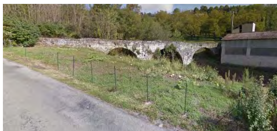
Un ancien aqueduc datant probablement du XVIIIème siècle, et son canal en pierre en amont et en aval
