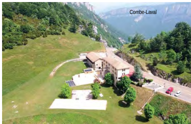
Vue depuis le sud de l'ensemble du site
