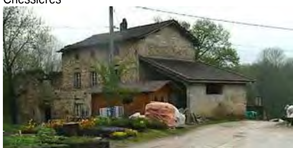
36 – Architecture domestique et agricole, les Chessières
