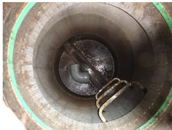
Regard n° 41 – Eaux usées
