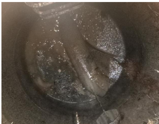
Regard n° 3 – Eaux usées
