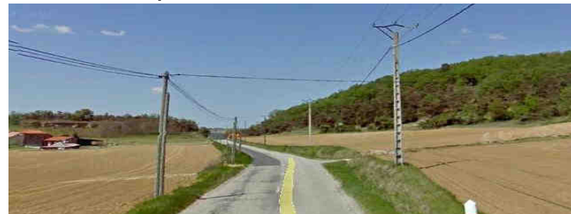
Col Route de la plaine RD 53
