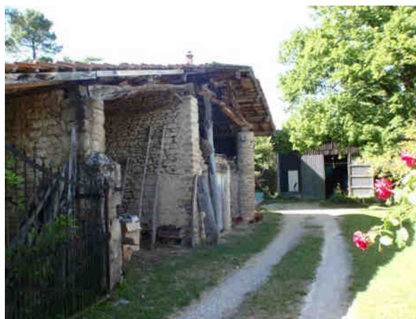
Bâtiment vue côté sud
