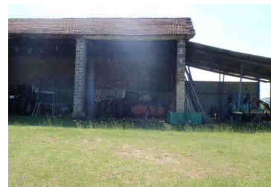
Bâtiment identifié : partie nord (partie hangar métallique non identifiée)
