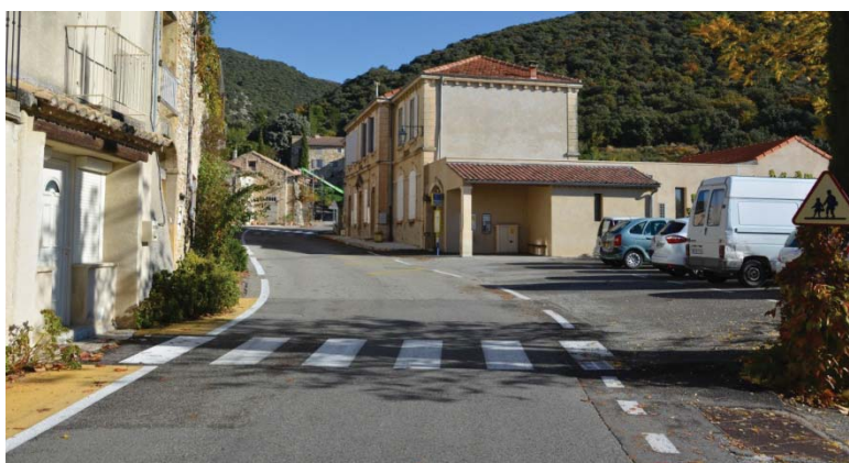
Dans la traversée de village, des trottoirs sont matérialisés par de simples bandes étroites de peinture jaune.
