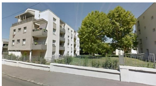
Photo et vue aérienne d'une opération référence (rue Charton, Oullins)
