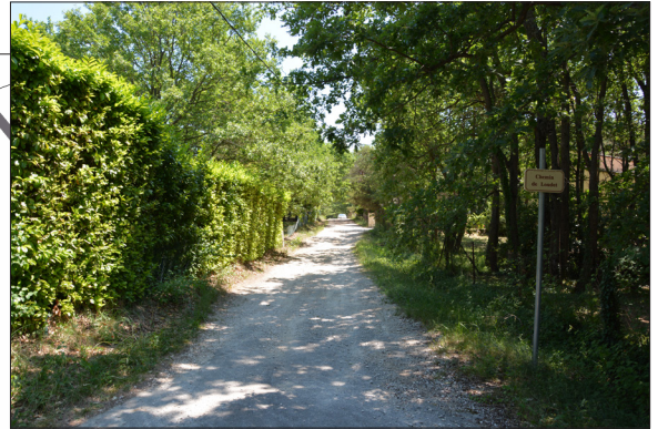
Le chemin «1» : un revêtement dégradé, une faible largeur.
