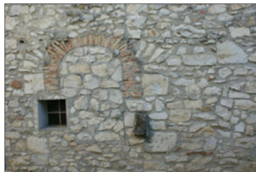
Une structures de maçonneries anciennes.
