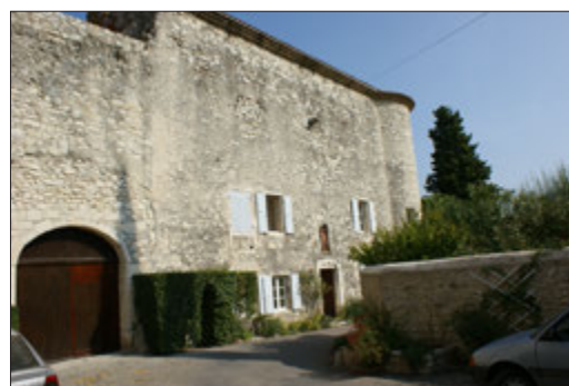
Structure du bâti du centre historique
