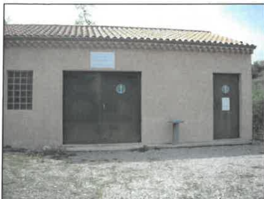
Photo 1 : Station de traitement de La Bourne
