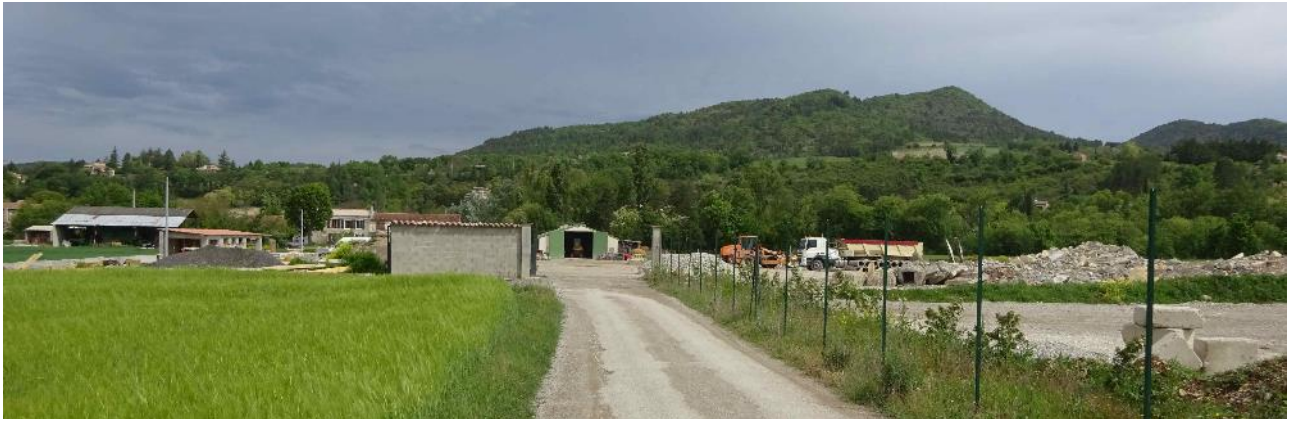
Approche du site, limite sud-ouest
