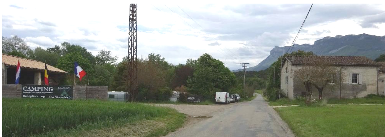
Accès depuis le RD, vue vers l'est
