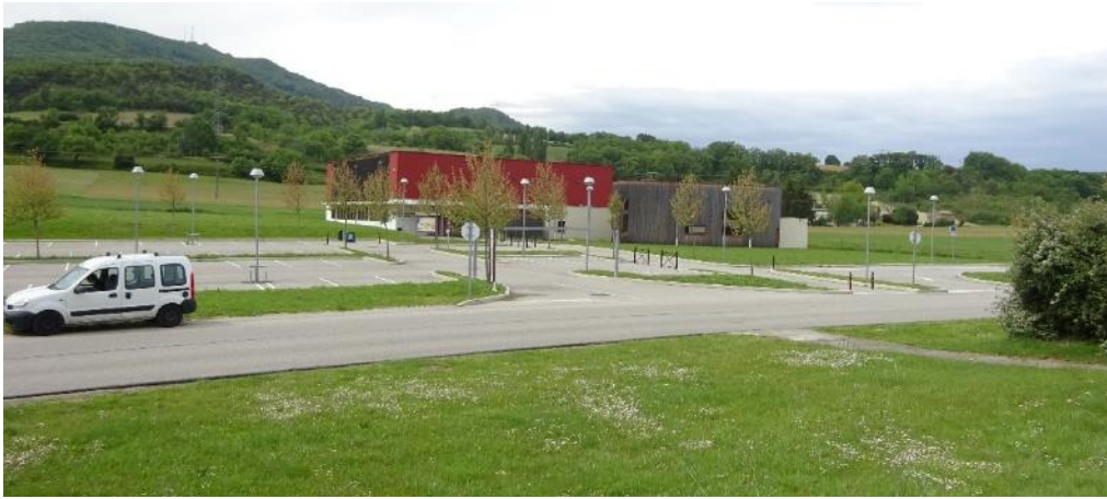
Gymnase Rif de Blanc, vu de la RD 164b (2017)
