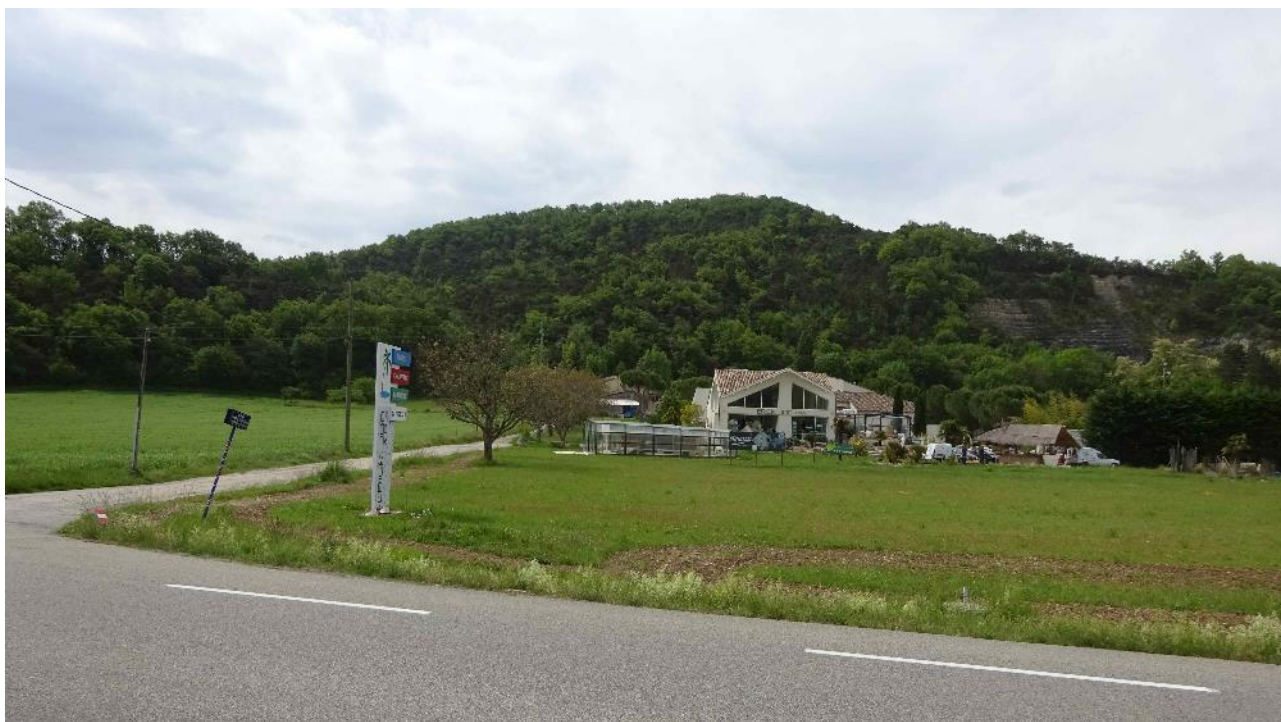
Vue depuis la RD 164 vers le sud
