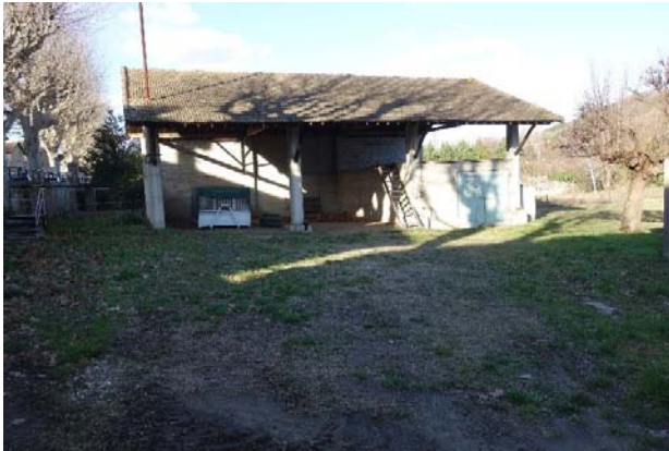
Aperçu de la grange.
