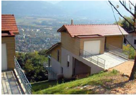
Accès par terrasses et passerelles
