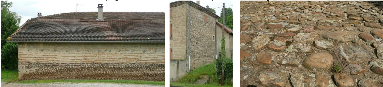
Bâtiment agricole avec soubassement en pisé, murs en pisé et couverture en tuile mécanique. / Maçonnerie en molasse apparente / Revêtement de sol réalisé en galets cassés (cour intérieure du Prieuré).
