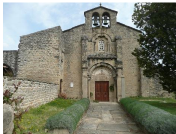
Façade principale ouest
