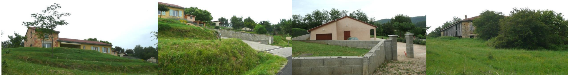
Les aménagements en pente ont entraîné des talutages. Les murets et murs de clôture attendent d'être enduits.
