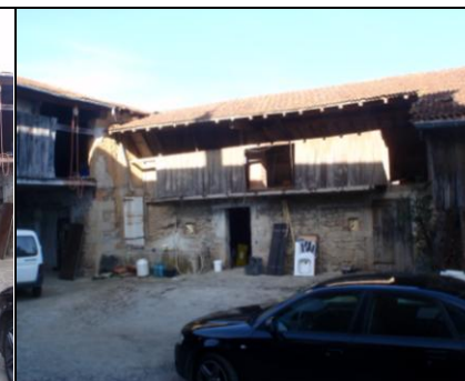
Grange : vue partie sud-est, côté cour
