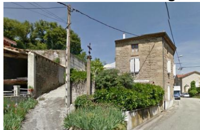
Vue du sud-ouest
