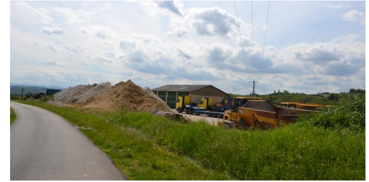
Dépôts de matériaux divers
