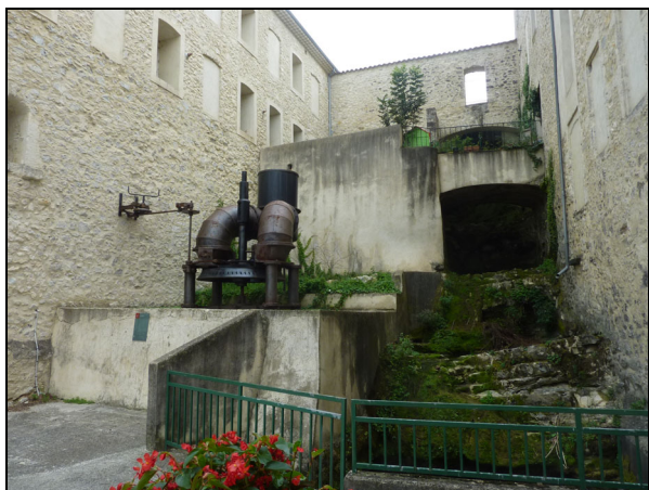
La turbine et le chenal
