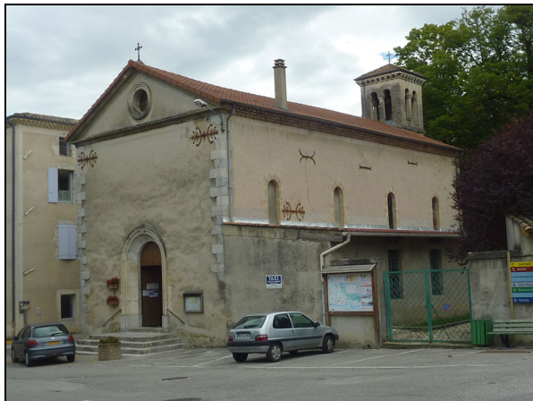
Eglise, Lieudit Blacons, parcelle AE 139
