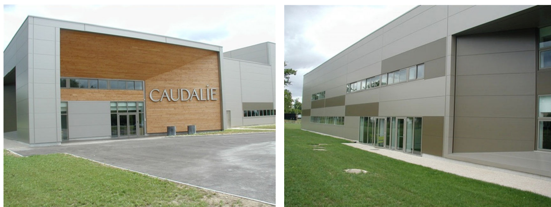
Exemples de revêtement de façade autorisés (1ère photo : bardage métal en combinaison avec bardage bois)
