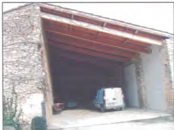
Annexe et remise faisant l'objet du changement de destination
