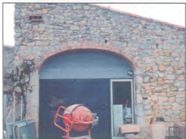
Remise faisant l'objet du changement de destination
