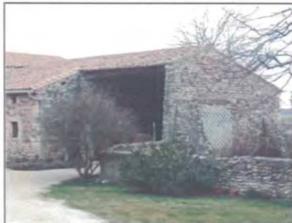
Remise faisant l'objet du changement de destination
