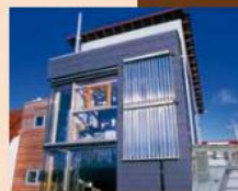
> Capteurs sous vide en façade
