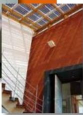
> Capteurs photovoltaïques semi-transparents en verrière
