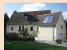
> Capteurs intégrés en toiture (CESI)
