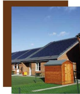
> Intégration photovoltaïque en toiture
