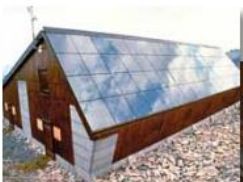
> Toiture complète en photovoltaïque
