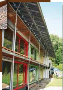
> Photovoltaïque en toiture avec auvent
