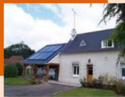
> Capteurs thermiques intégrés en toiture secondaire (Chauffage)
