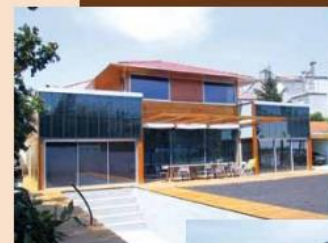
> Capteurs thermiques en façade (Chauffage)
