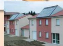
> Couverture totale en capteurs solaires thermiques (Chauffage)
