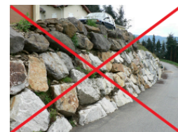
Exemple d'enrochements de type cyclopéen
