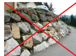
Exemple d'enrochements de type cyclopéen
