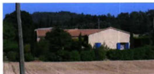
Exemple de construction récente Quartier des Touches
