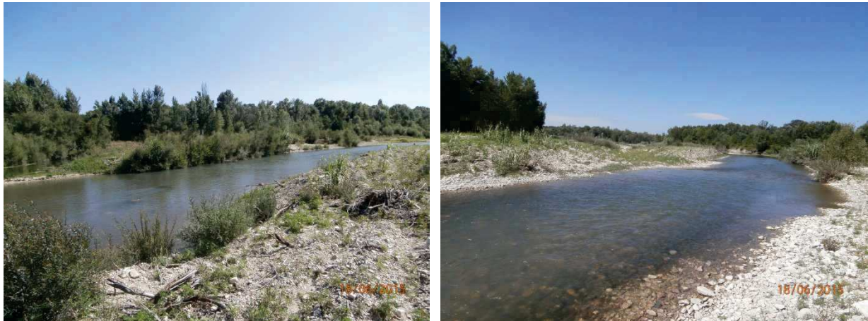
Figure 17 : Vues du Roubion au droit de la zone de travaux
