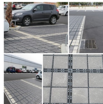
Parking réaménagé avec un système d'infiltration au sol
