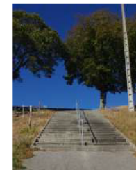
3. Vue des escaliers vers la RD66
