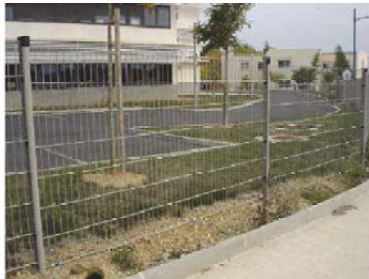
Clôtures en grillage en treillis soudé
