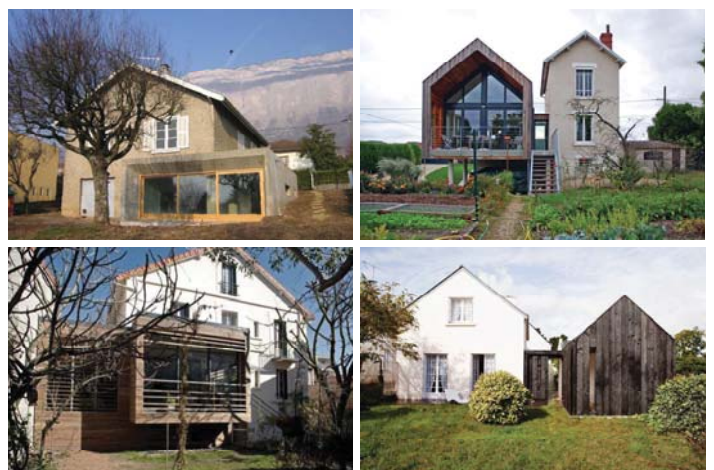
Exemples d'extension au vocabulaire architecturale différent du bâtiment initial
