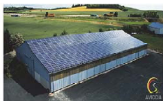
Toiture onéride : - toiture complète - faible pente
