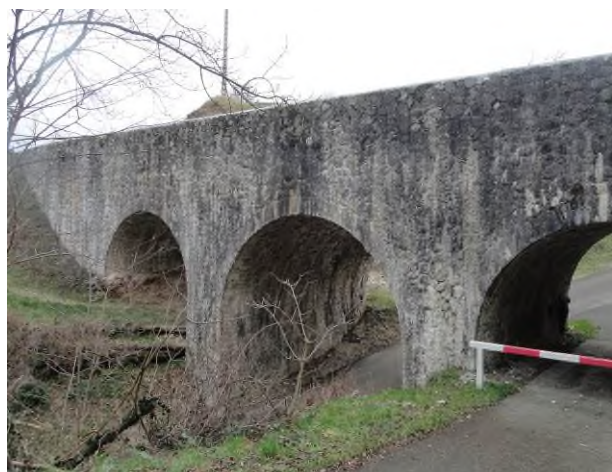
Aqueduc du canal de la Bourne
