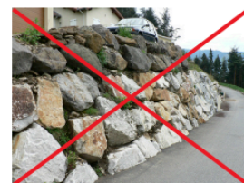
Exemple d'enrochements de type cyclopéen
