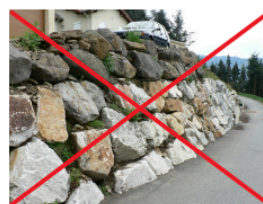
Exemple d'enrochements de type cyclopéen
