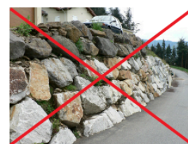
Exemple d'enrochements de type cyclopéen
