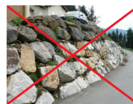
Exemple d'enrochements de type cyclopéen
