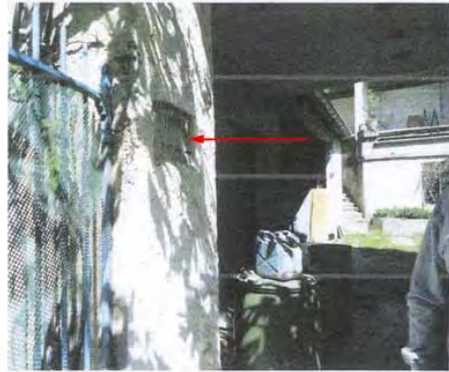
Emplacement repère n°3
