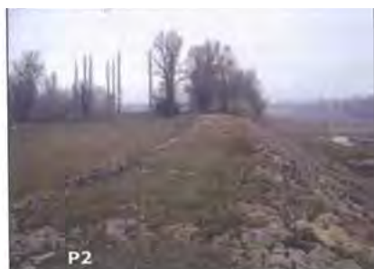
Digue de Chatelas – zone enrochée (photo Prolog)
