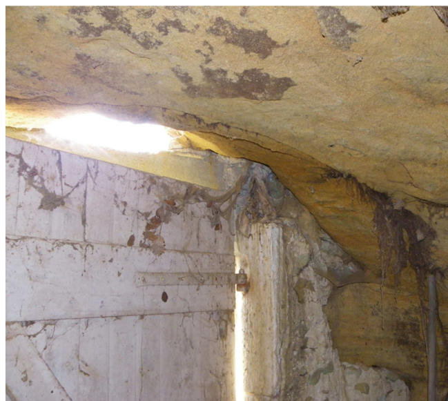
Figure 5 : Exemple d'une cavité avec fissure sur l'entrée (n°27)
