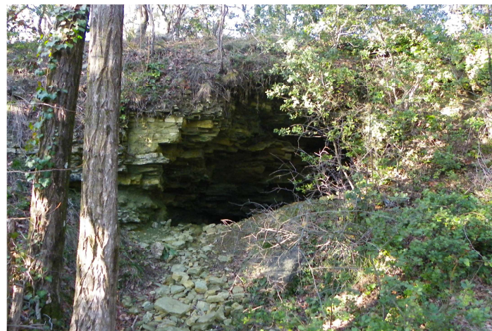
Figure 7: Entrée d'une cavité creusée dans les niveaux calcaires de la base des grès verts coniaciens (n°33).
