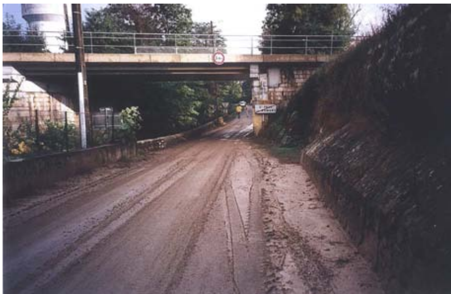
Débordement de la Joyeuse sous le passage de la voie ferrée
