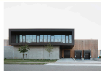
Façades béton-bois-métal en lien avec les fonctions
