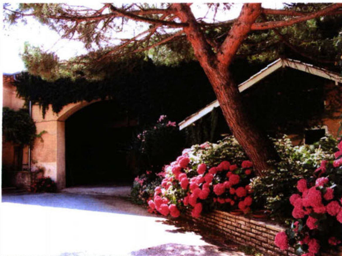
AILE SUD VUE DE LA COUR INTERIEURE
