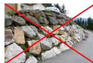
Exemple d'enrochements de type cyclopéen
