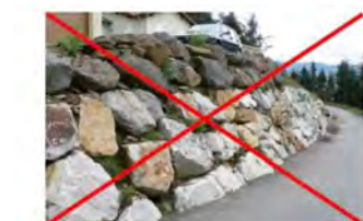
Exemple d'enrochements de type cyclopéen
