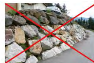
Exemple d'enrochements de type cyclopéen
