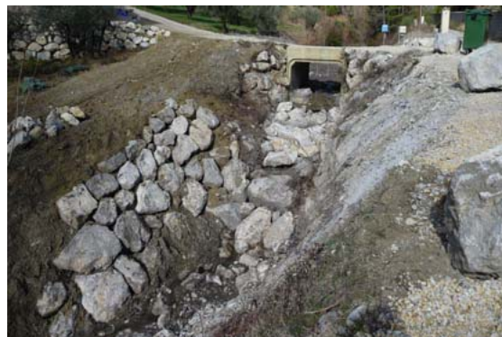
Février 2011 Protection du seuil par enrochement
