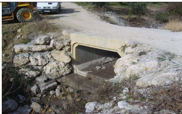
Seuil sur ouvrage amont
