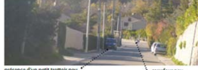
présence d'un petit trottoir peu matérialisé et utilisé pour le stationnement carrefour peu perceptible
