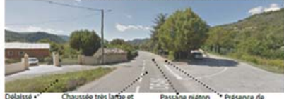
Délaissé routier Chaussée très large et carrefour surdimensionné Passage piéton peu lisible Présence de trottoir mais pas de continuité
