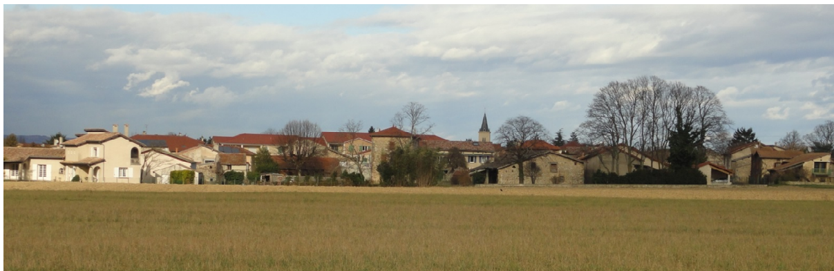
Vue depuis le Sud
