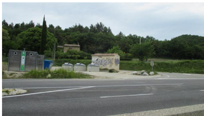
Vue sur le carrefour entre la RD 540 et la route de Châteauneuf
