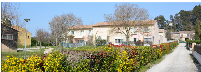
Parallèlement à l'essor d'un habitat peu dense, L'opération des Albizzias avait introduit un modèle d'urbanisation organisé et dense, dont les premiers héritières ont été les zones d'habitats récentes du chemin de la Trimone. L'objectif est de s'appuyer sur cet héritage en lui associant des modalités plus poussées d'intégration urbaine, d'insertion paysagère.
