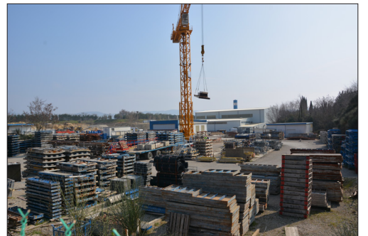
Les activités du BTP sur le site de la carrière.
