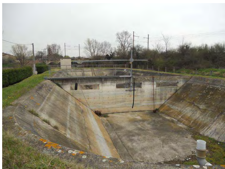
Ancienne station communale d'Andancette
