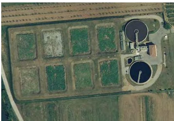
Station intercommunale actuelle
