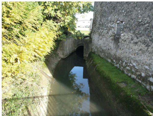
Sortie de la partie enterrée sous l'aérodrome
