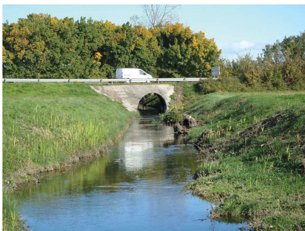
Franchissement de la RD 11
