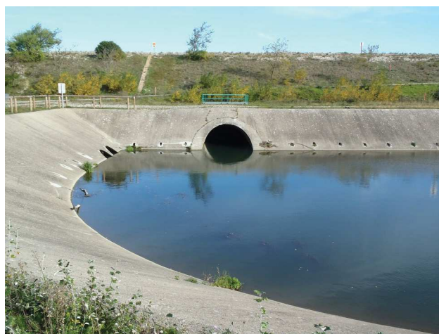
Sortie du siphon sous le canal CNR
