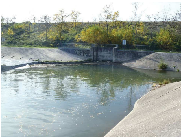
Siphon et arrivée des deux contre canaux
