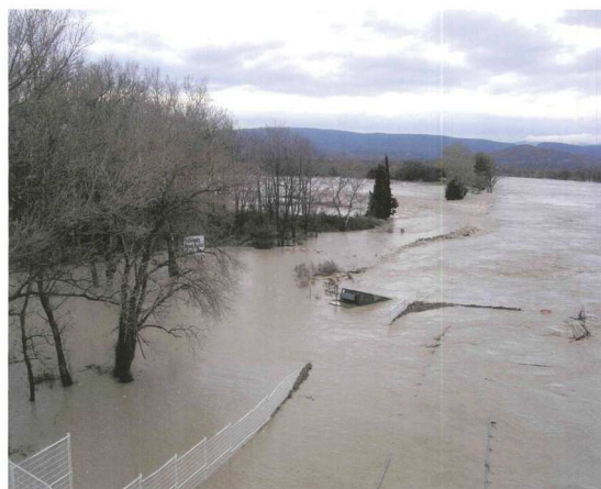
Décembre 2003 – aval barrage de Donzère (photo DDE)
