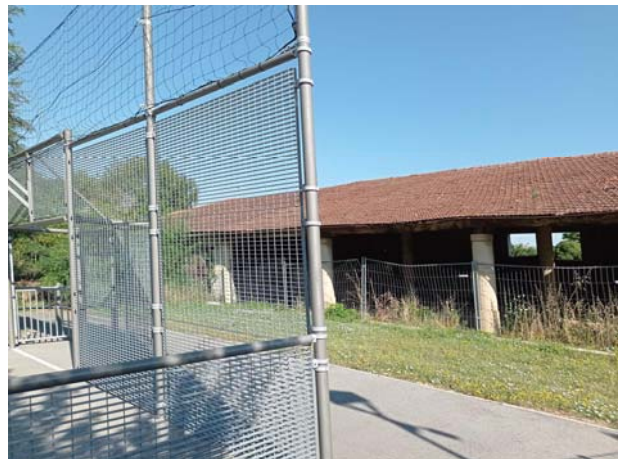
Vue depuis le city-stade au sud – façade sud sur parc
