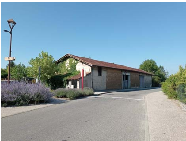
Bâti existant qui sera détruit : façade nord sur rue
