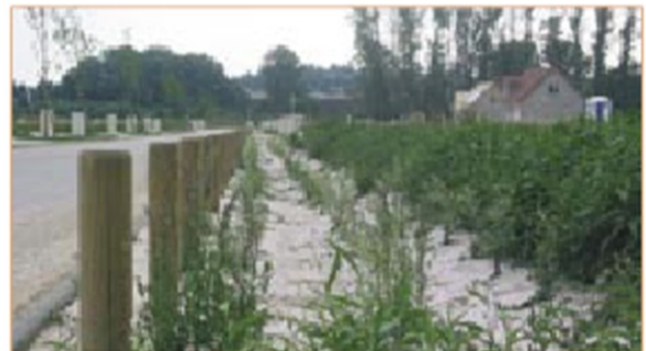
Une noue collectrice des eaux pluviales.
