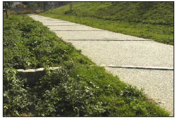
Allée piétonne et sa noue latérale
