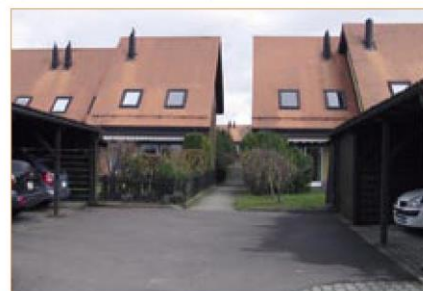
Le regroupement des garages permet de minimiser les nuisances liées à la circulation dans le reste du quartier.
